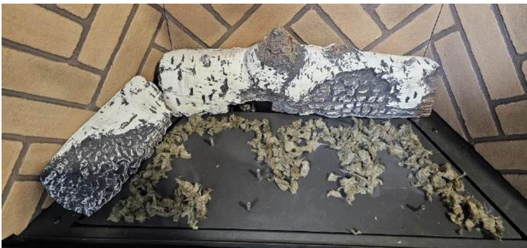
Position Log #2 on the left side of the firebox as shown above / Positionnez le journal #2 sur le côté gauche de la chambre de combustion comme indiqué ci-dessus
